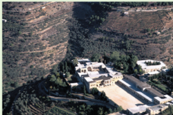
Vue aérienne du palais
